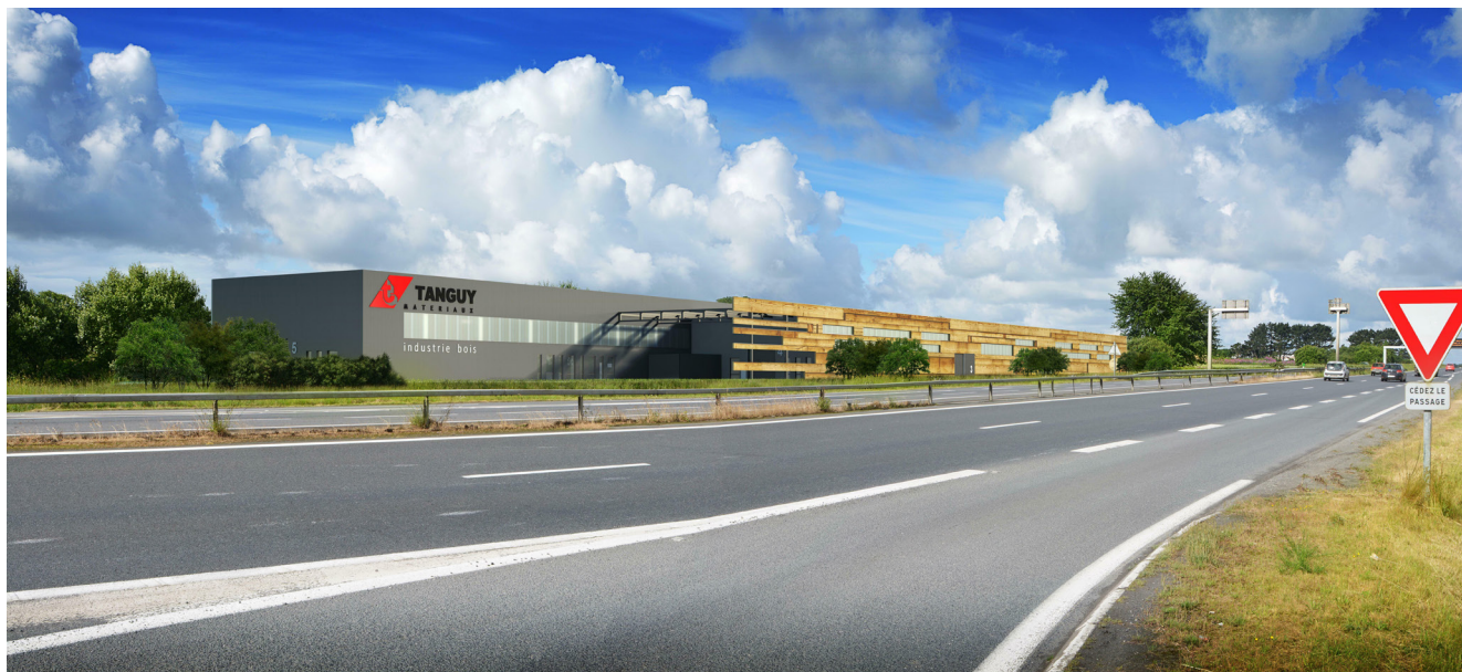
Usine de Tanguy Matériaux (Saint-Eloi Nord - Plouédern)
