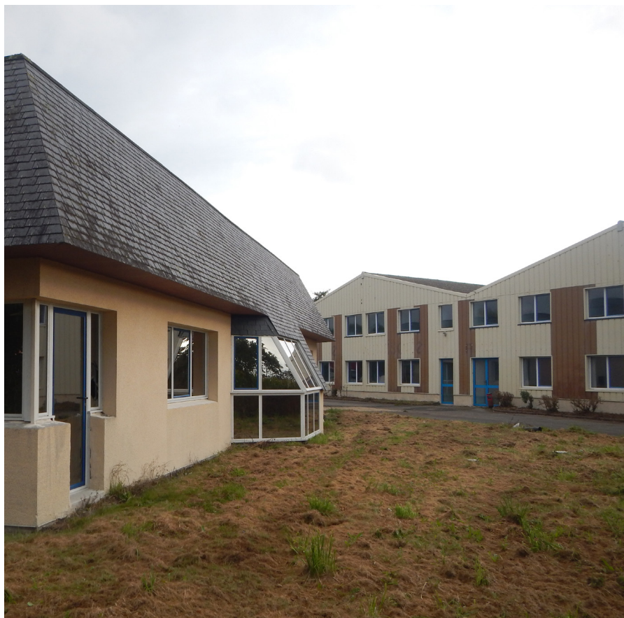
Ancien site de Le Got Industrie (Kernévez - Le Drennec) - Photo Adeupa
