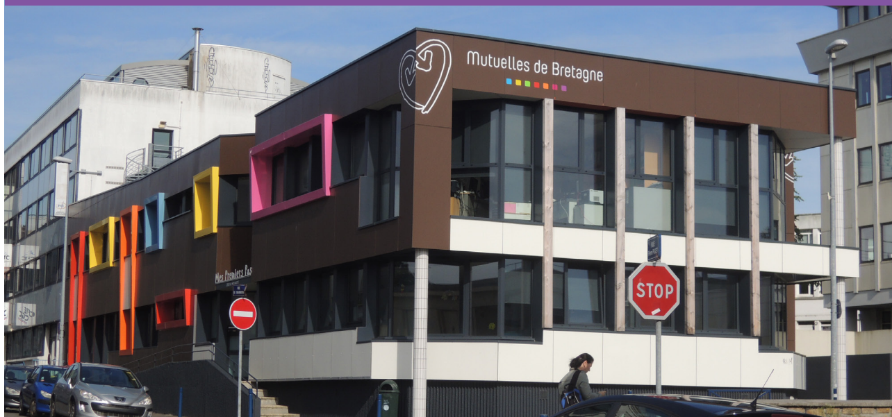
Opération de réhabilitation urbaine par la crèche mutualiste Mes Premiers Pas (centre-ville de Brest) - Photo Adeupa
