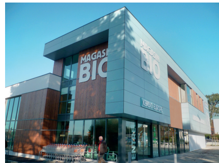
Quartier Europe à Brest - Magasin bio (déconstruction-reconstruction dans le cadre d'une opération de renouvellement urbain) - Crédit : Kerbio Europe
