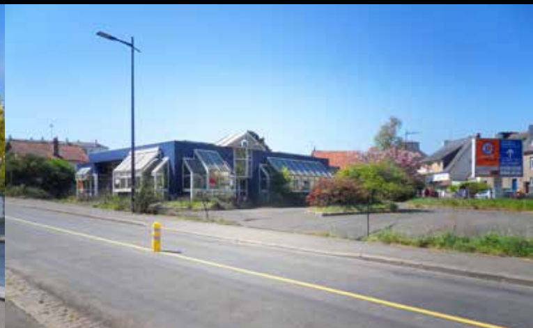
L'angle du boulevard de la Marne et de la rue Luzel
