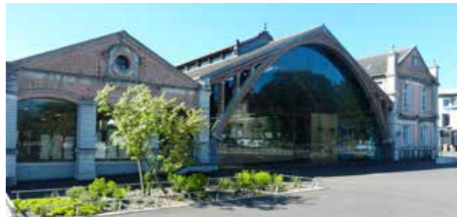
Ancienne gare Saint-Brieuc-Centrale
