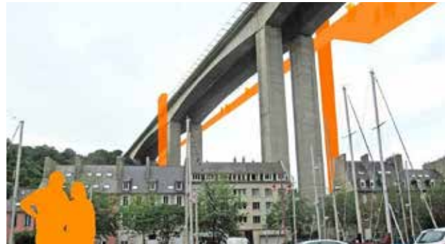
Le viaduc de la RN12 augmenté et connecté au port
