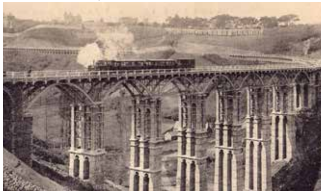
Viaduc de Toupin et vue d'ensemble des Nouveaux Boulevards, ligne de St-Brieuc-Moncontour
